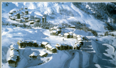
1972 Début des travaux de construction de Plagne Villages.
