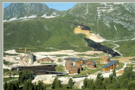
1981 Ouverture de Belle Plagne, station intégrée à 2100 m. d'altitude.
